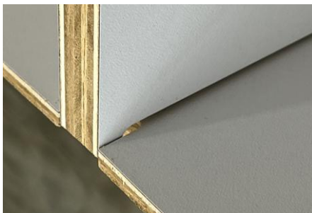
Tipp: eingesägte Streifen mit Rückseite der Säge herausschlagen (Abb.3).
