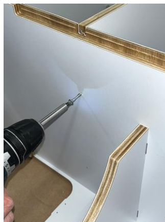
Verschraubung Böden / Seiten: Schrauben 4,5 x 40 mm.
