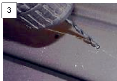
Abb. 3-1: Bohrung der vorderen Befestigungspunkte / Drill the front attachment points
